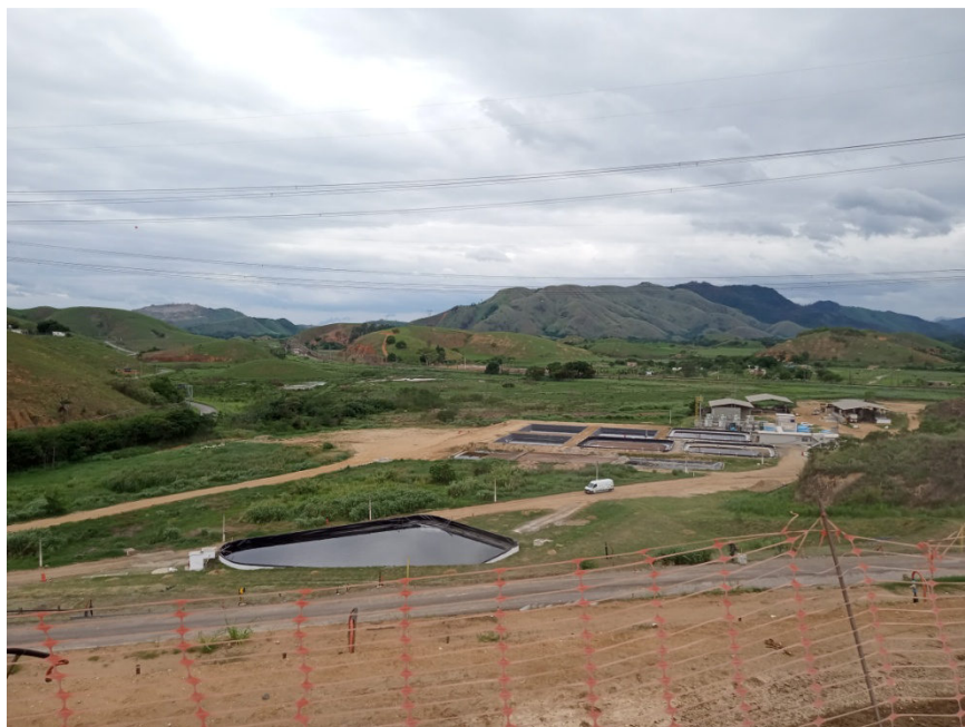
Figura 9: Vista aérea das novas lagoas
