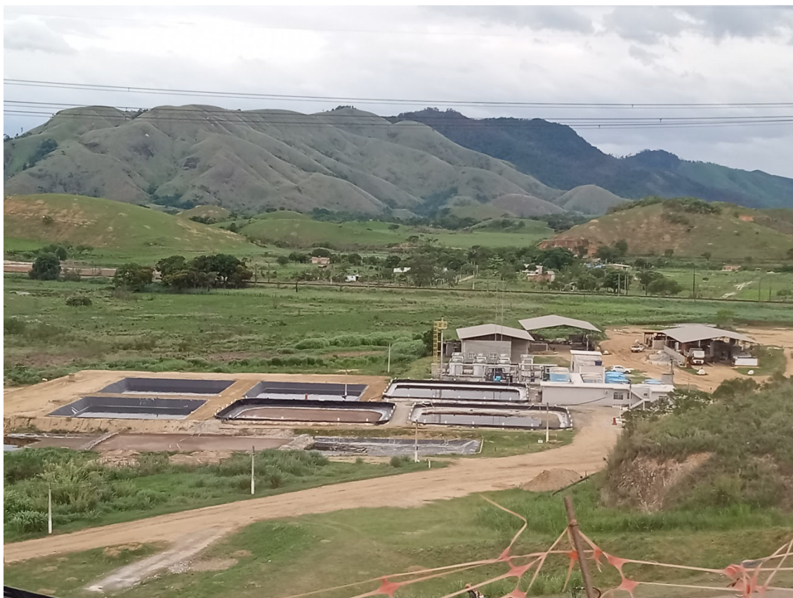
Figura10: Vista aérea das novas lagoas
