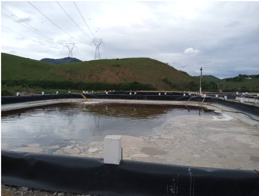
Figura11: Lagoa de recebimento de chorume
